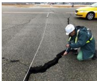
空港基本施設(滑走路等)の調査
